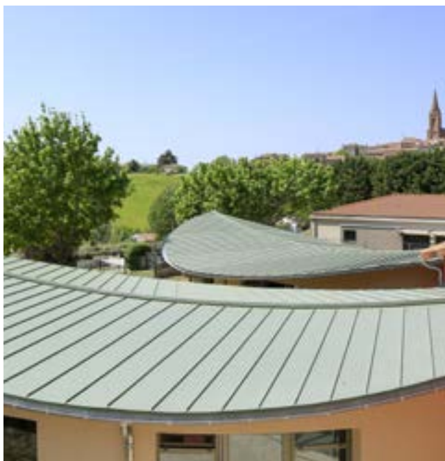
Cubierta en Junta alzada VMZINC® - PIGMENTO® verde - Arquitecto: Bamboo - Caraman - Francia
