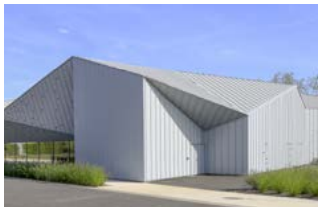
Cubierta en Junta alzada VMZINC®, Chapas perforadas - AZENGAR® bajo pedido - Arquitecto: Vignault x Faure - Pornic - Francia
