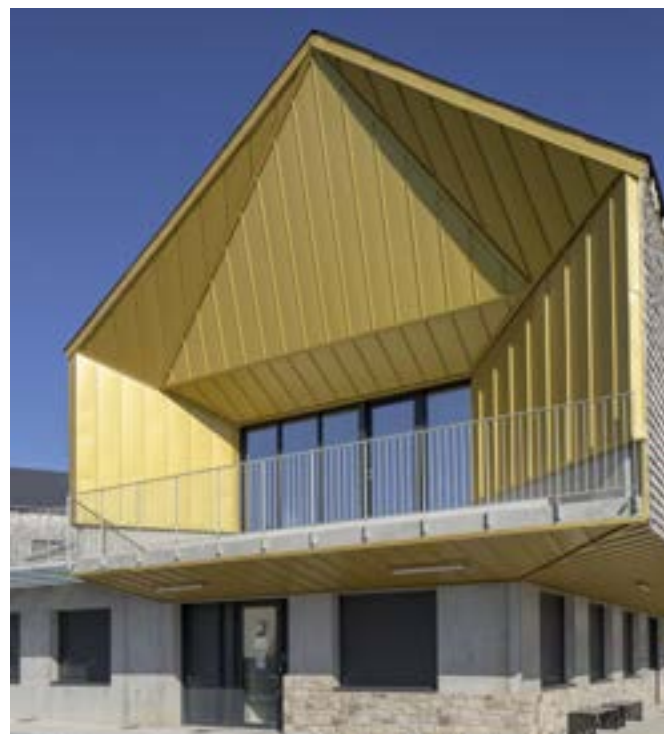
Cubierta en juntaalzada VMZINC® - ORO LACADO n°691 - Arquitecto: Vignault x Faure - Crac'h - Francia
